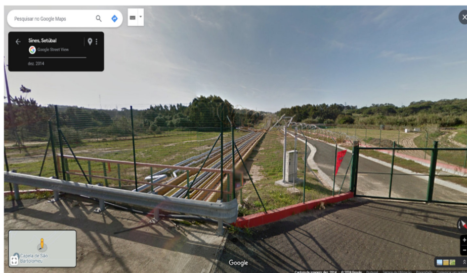
Figura 8- Pipelines já existentes sobre a Ribeira de Moinhos.
