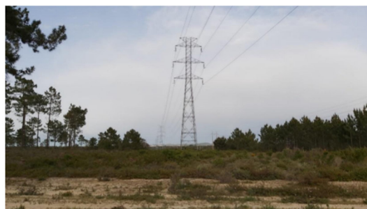
Figura 4.52 – Corredor da Linha Elétrica a sul
